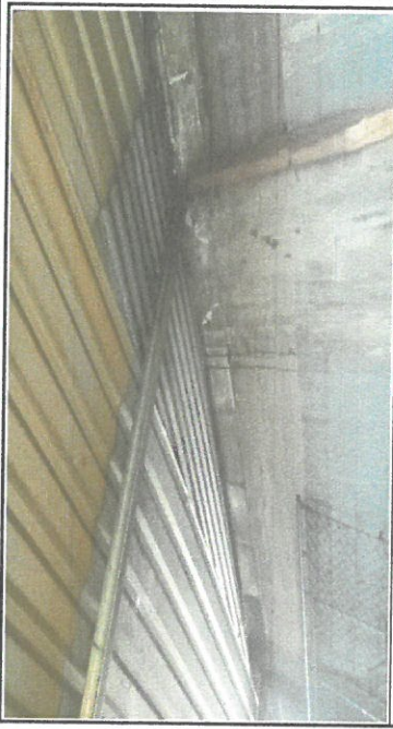
Foto 2: vista frontal de cambio de estructura
